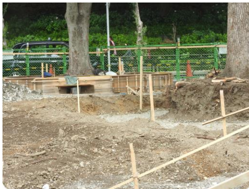
不忍池入り口の工事現場
