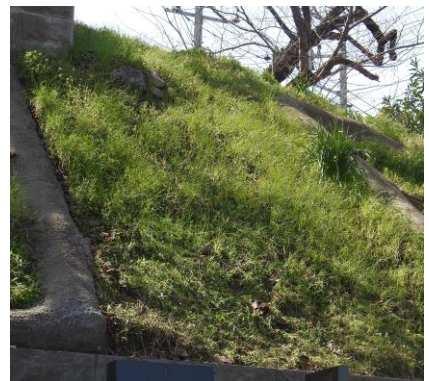
↑除草後(手前側を除草)
